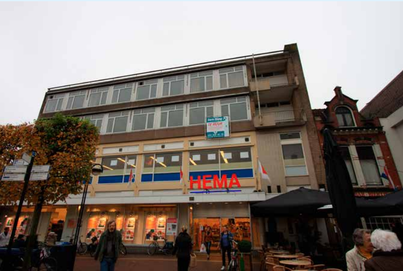
Leegstaande kantoorroimte boven de Hema in de binnenstad van Almelo. (Foto: RUIMTEVOLK)
