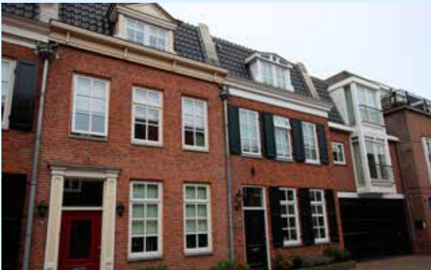
NIEUW HISTORISCH WONEN Nieuwbouw van historische woningen in de binnenstad van Almelo (Foto: RUIMTEVOLK)
