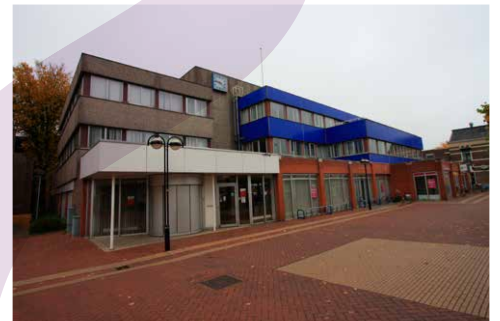
VEROUDERD KANTOORGEBOUW, ALMELO Ook binnensteden hebben te maken met leegstand van verouderde kantoorgebouwen, zoals hier in Almelo. (Foto: RUIMTEVOLK)
