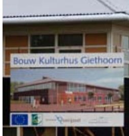
32) Kulturhus in aanbouw.
